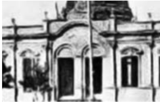
1907-1927 Vista frontal del edificio. Acceso de doble arcada con una columna central.
